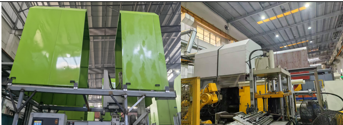
图 4-1 压铸工序废气收集系统
